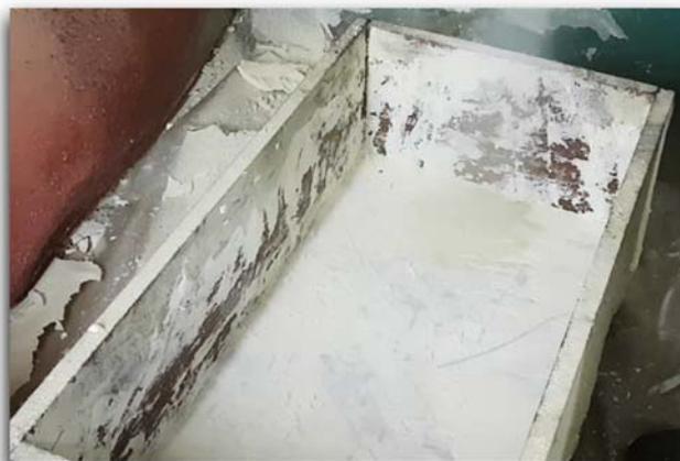
Projeter le liquide sur le support, la mousse doit être expansé de manière à complètement remplir le cadre
